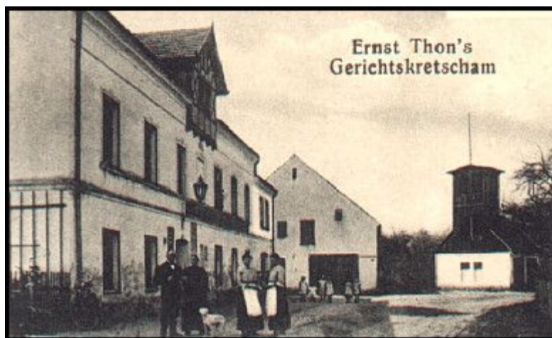
Świetlica oraz w głębi po prawej stronie remiza strażacka
